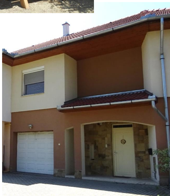
Bejárat kialakítás az északi lakótelep városrészeiről. Modern formák, harmonizáló színek és anyagok összehatása pozitív arculatot kölcsönöz az épületnek.
