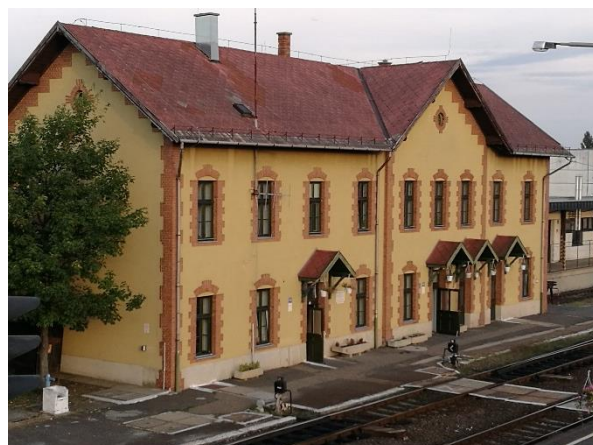
Régi vasútállomás épülete
